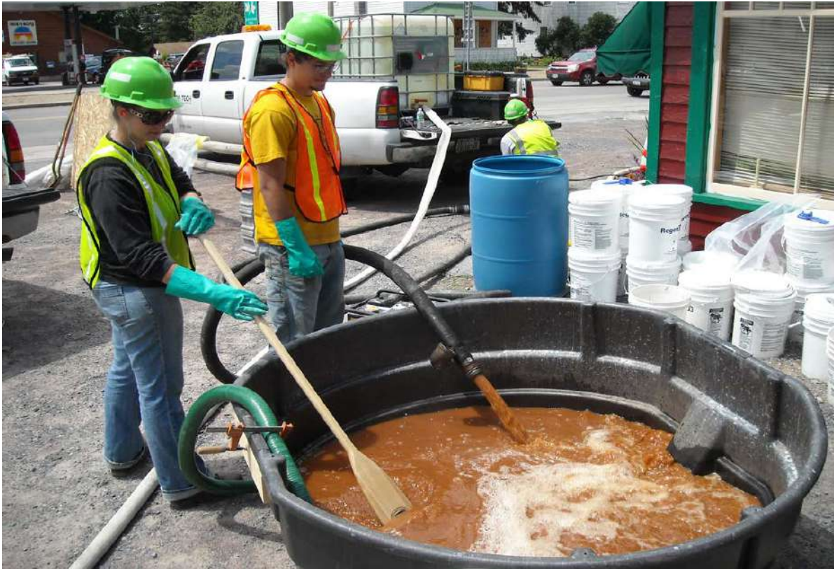
Figure 2.5 – Mélange des réactifs avant l'injection
