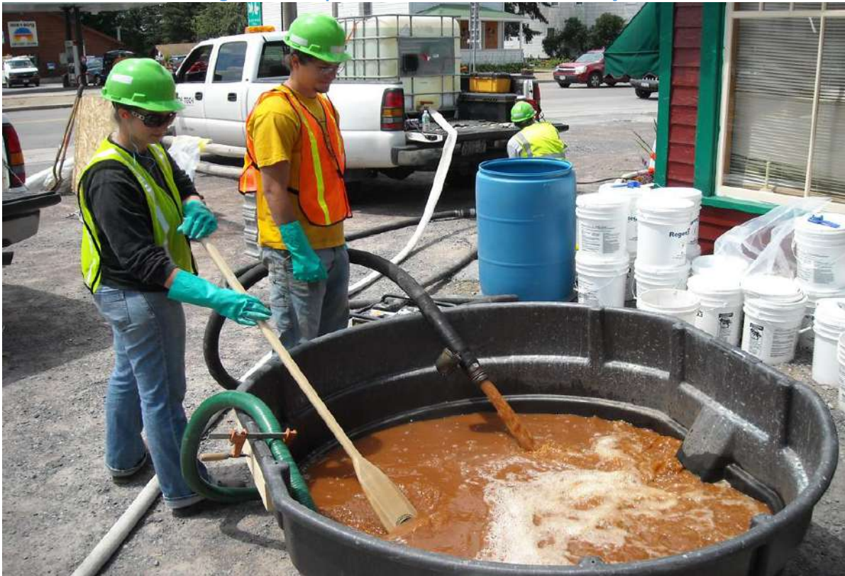
Figura 2.5- Mistura de reagentes antes da injeção
