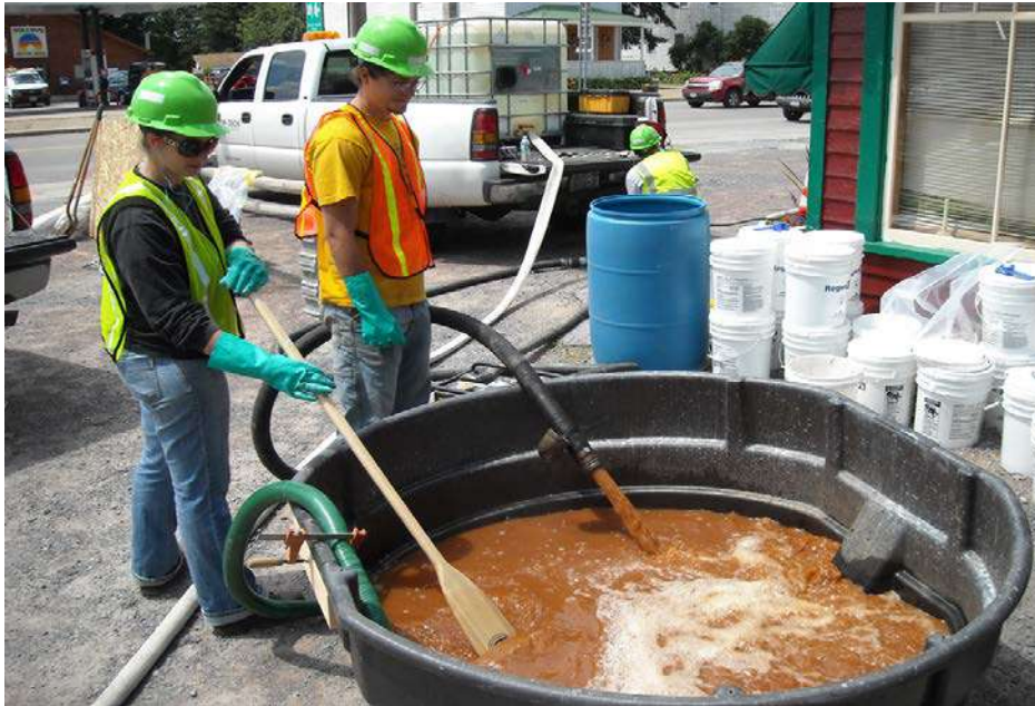
Figuur 2.5 - Mengen van reagentia vóór injectie
