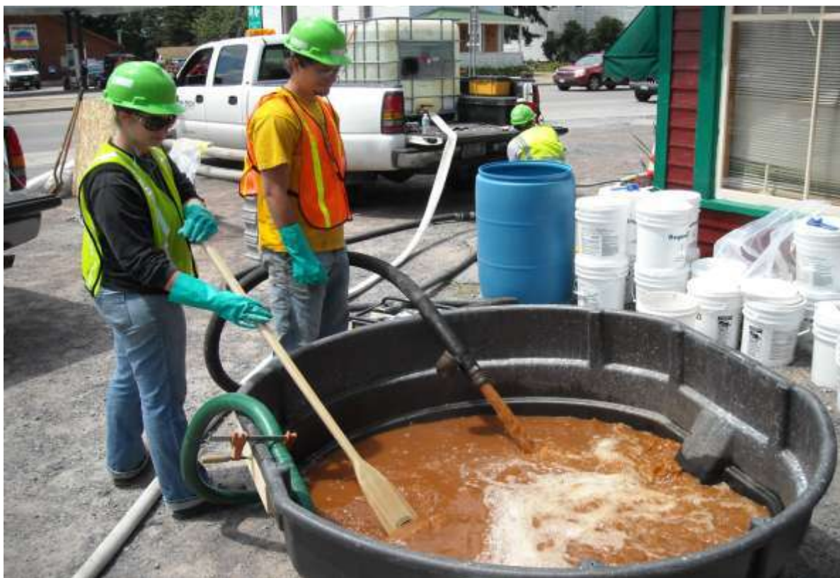
Figura 2.5- Preparazione della soluzione da iniettare
