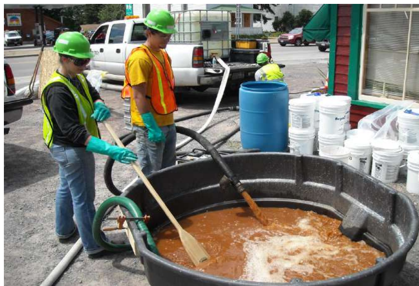
Figura 2.5- Mezcla de reactivos antes de la inyección
